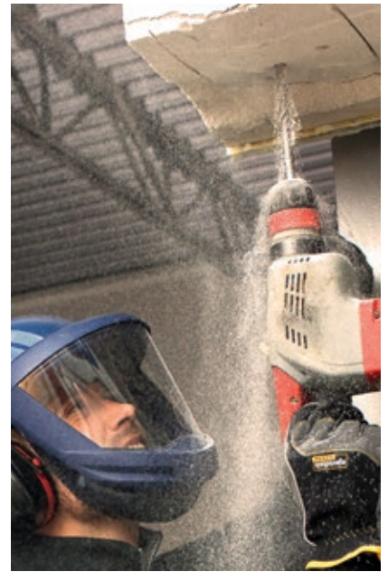
Casco con visera SR 580 o pantalla facial SR 570 con o sin gorra de seguridad dependiendo de la situación de trabajo.
